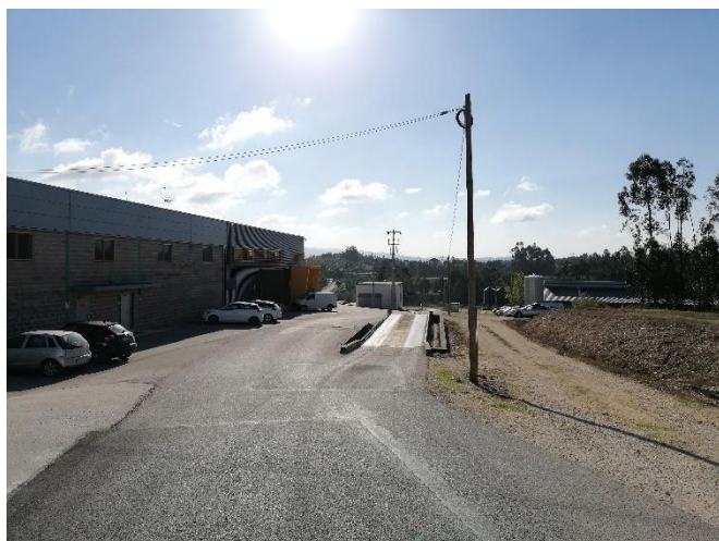
Figura 6.3 – Zona da Balança de pesagem de veículos
