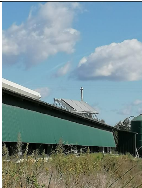
Figura 6.7 – Painéis Solares existentes na instalação, junto dos pavilhões de recria
