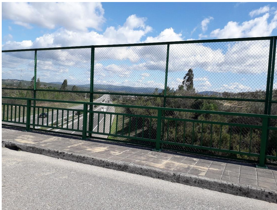
Figura 7.62 – Vista da principal via de acesso á área em estudo – A1
